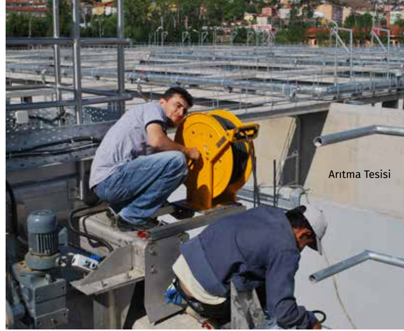
Vinçlerde Kullanılan Yağ ve Enerji Aktarım Tamburu
